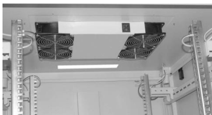
Установленный вентиляторный блок в шкафу
