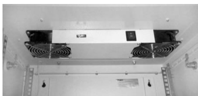
Установленный вентиляторный блок в шкафу
